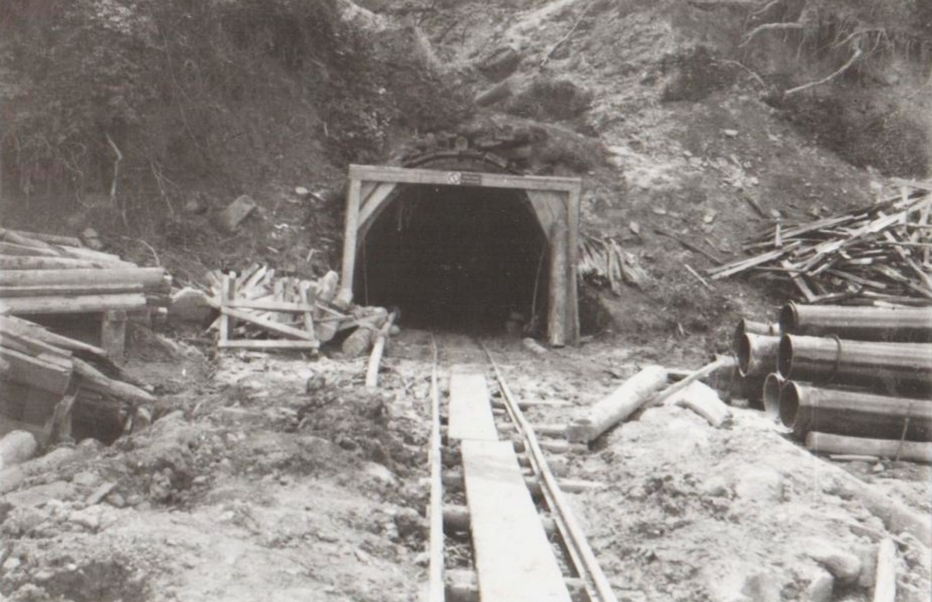
prieskumná štôľňa na vyhľadávanie ortuťovej mineralizácie – rumelky (Ladomírov)
